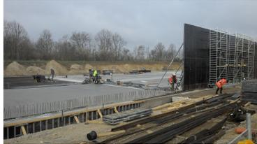
Erstellung der Bodenplatte eines Hochregallagers sowie Rohbau der Kommissionierung inkl. Ausführung der Erd- und Kanalarbeiten sowie der Außenanlagen für die Eppendorf AG.
