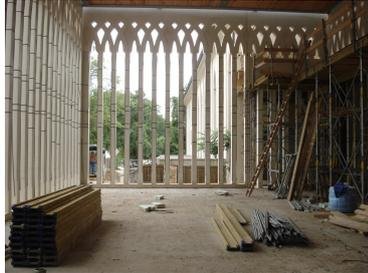
Rohbau eines Gebäudes für das spätere Zoorestaurant westlich des Weißen Saals der Kongreßhalle im Leipziger Zoo. Die Bauausführung der Fassade mit den schlanken Stützen und der Ornamentattika wurde auf Vorschlag des Auftragnehmers mit Fertigteillementen realisiert.
