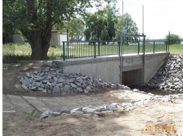
Teilabbruch des Ein- und Auslaufbauwerks, Herstellung einer Betonvorsatzschale in Sichtbetonqualität, Montage eines Grobrechens. Instandsetzung von vier Stahlbetonschächten, Ausstattung mit Edelstahldeckeln.
