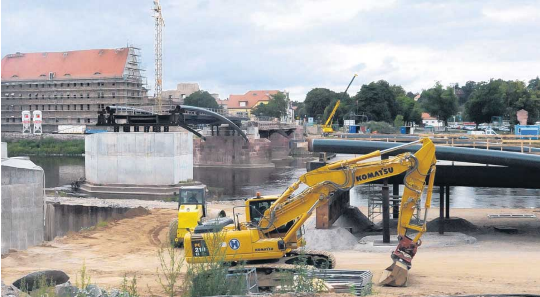
Wartet auf die sehenswerte Schwebemontage: Die zweite Hälfte des großen Stahl-Sprengwerks (rechts im Bild) wird jetzt am Ostufer der Mulde so weit vorbereitet, dass sie Mitte August auf die Pfeiler aufgesetzt werden kann. Der weiße Beton-Hilfspfeiler in der Flussmitte wird nach Abschluss der Brückenbauarbeiten entfernt. Foto: Andreas Röse
