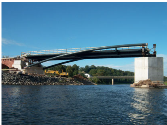
Sanierung der 2002 durch das Hochwasser beschädigten Pöppelmannbrücke in Grimma (Foto: Otto Heil)
