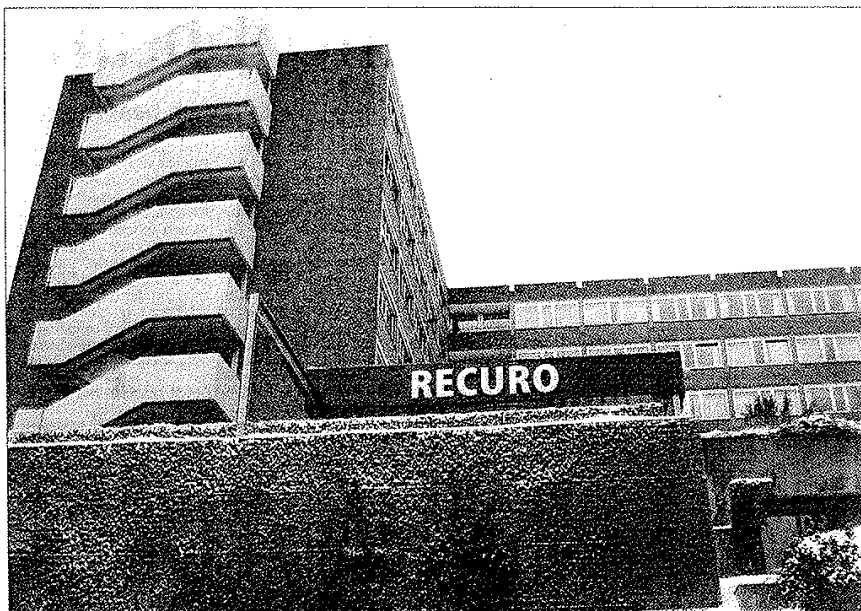
Seit Anfang des Jahres ist die ehemalige Klinik „Regina“ der Deutschen Rentenversicherung Bayern Süd wieder auf dem Markt. Der neue Eigentümer, das Rehabilitations- und Präventionszentrum Bad Bocklet, steckte rund sechs Millionen Euro in das Haus, das sowohl im Bereich der Patientenzimmer als auch im medizinischen und therapeutischen Bereich auf den neuesten Stand gebracht wurde.
